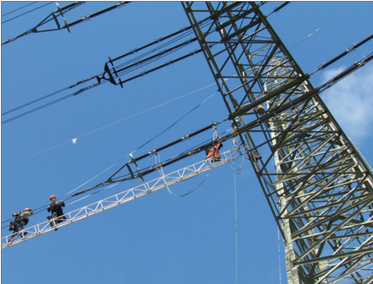
Construction de lignes électriques aériennes
