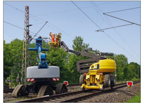
Construction de caténaires
