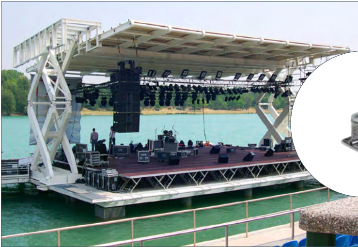
Les vérins à vis sans fin optimisés de Pfaff-silberblau soulèvent et abaissent le toit de la scène de Milan de manière fiable et, surtout, en toute sécurité.
